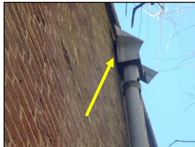
Figuur 23. Ruimte achter regenpijp.
