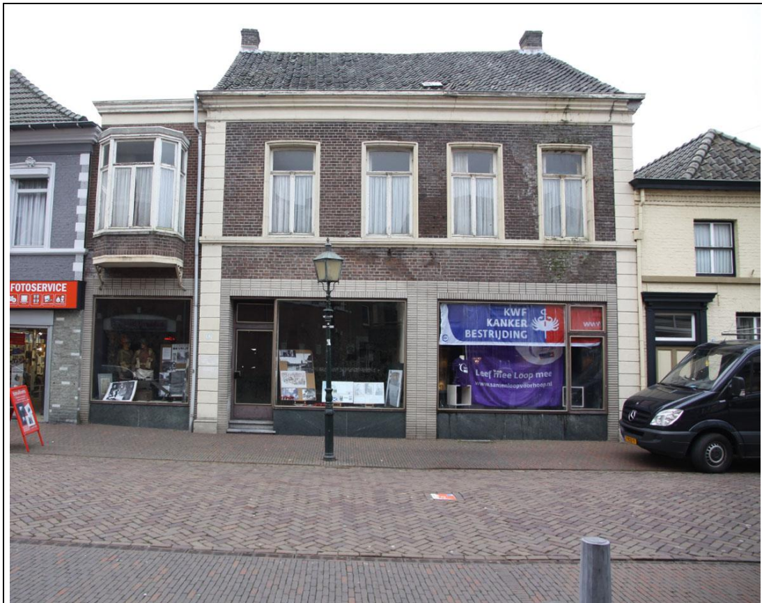
Afbeelding 4: Foto bestaande situatie.
