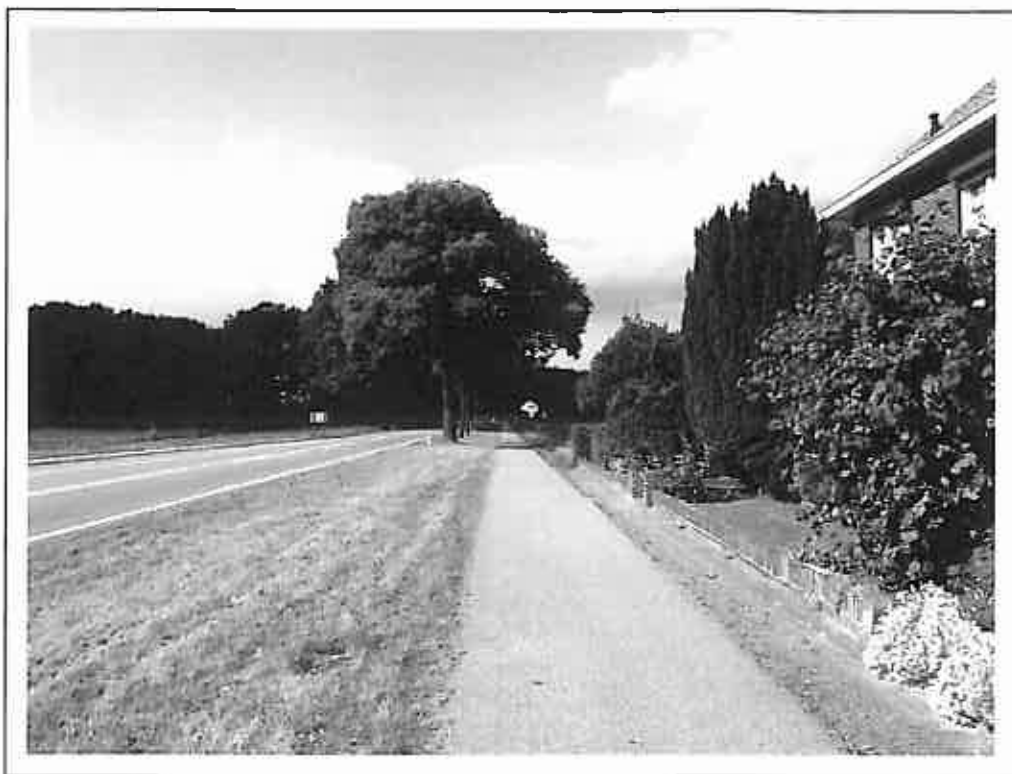
Foto 3. gedeelte van te vernieuwen fietspad en Rijksweg met gemaaide tussenbem
