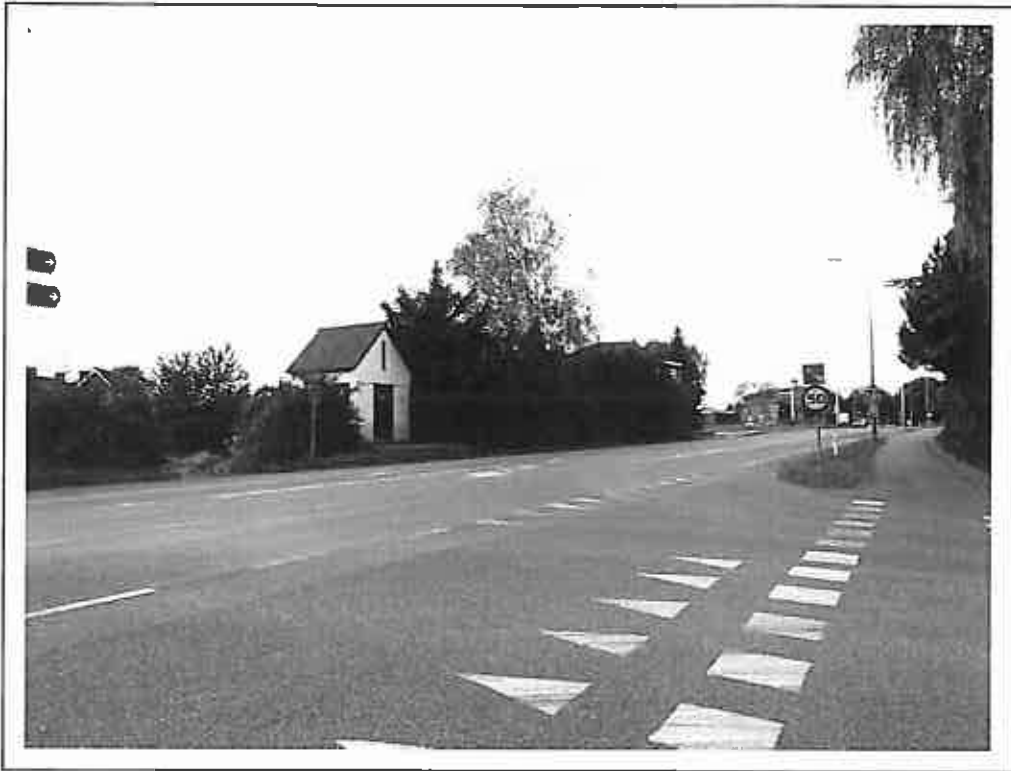
Foto 1. kruispunt Rijksweg met Zwarteweg, waar zuidelijke rotonde wordt gerealiseerd
