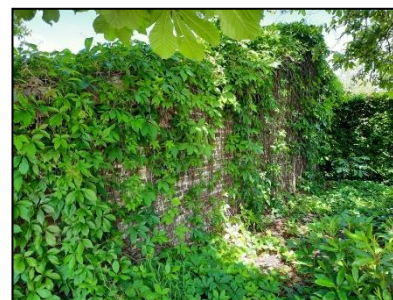
Figuur 5. Zuidzijde bebouwing onderzoekslocatie. Kijkrichting noordelijk.
