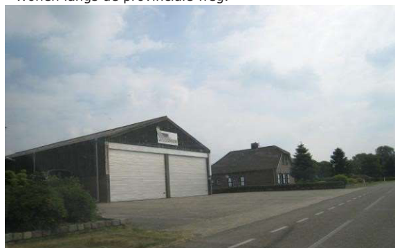
Werken langs de provinciale weg.
