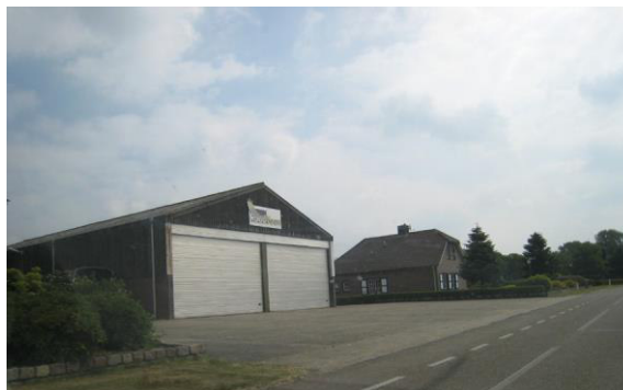
Werken langs de provinciale weg.
