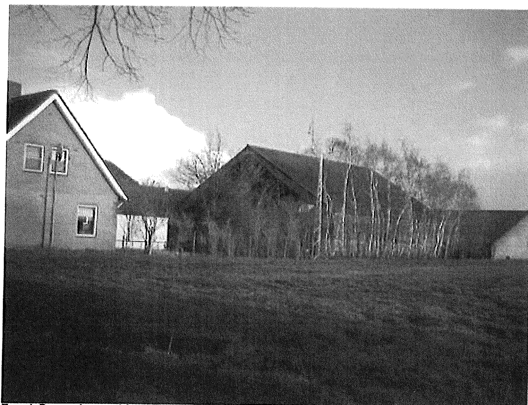
Foto 4: Bestaand aangezicht vanuit rechterzijde bedrijf.
