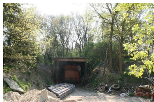
Foto 1.8 De oude te slopen loods
