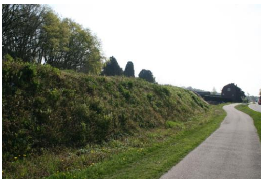
Foto 1.5 Grondwal tussen kavel en fietspad
