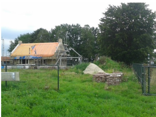
In aanbouw zijnde woning gezien vanaf het noorden.
