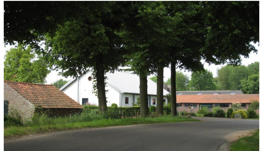
Door het lichte kleurgebruik van zowel gevel als dak is een te groot contrast ontstaan met de omgeving.
