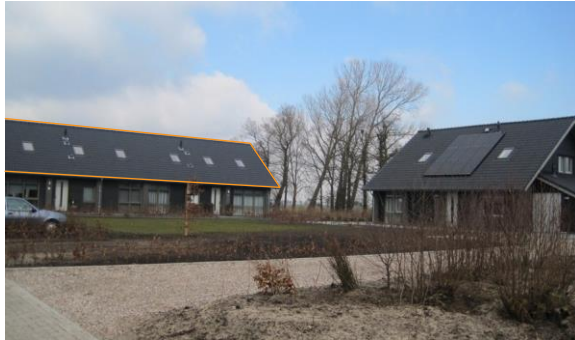
Een flink zadeldak waarop matte zonnepanelen nauwelijks afsteken bij de donkere dakpannen.
