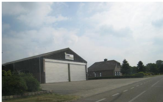
Werken langs de provinciale weg.
