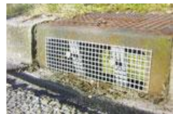
Figuur 8. Paddenstelling op trottoirkolk (bron: Arfman Hekwerk b.v.)
