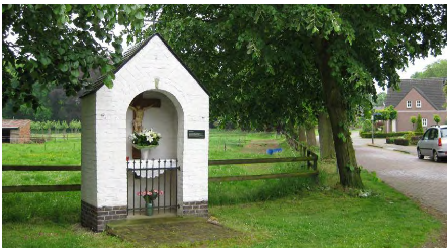
Afb. 3.34 De in 1910 gebouwde veldkapel aan het begin van de oprijlaan
