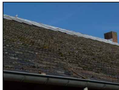
Figuur 5. Dakconstructie met in de nok een lichtstraat.
