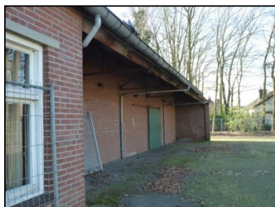
Figuur 6. Oost- en westzijde loods met overkapping.
