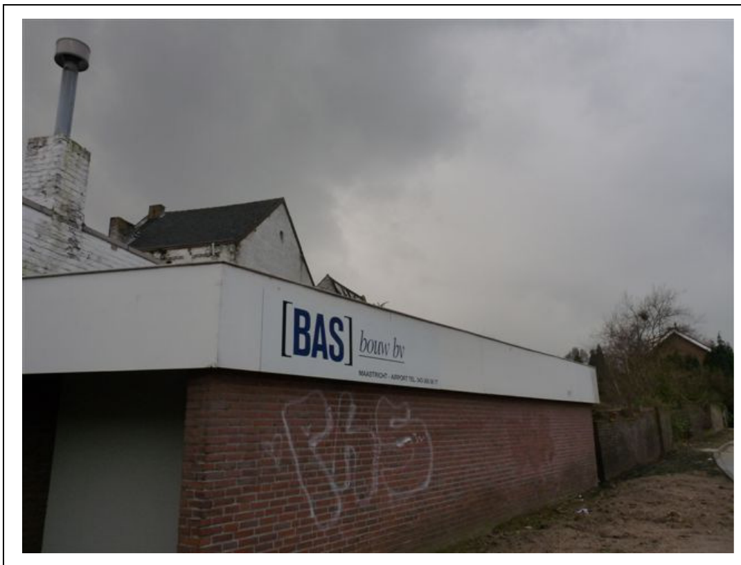
Foto 3. Betimmeringen buitenzijde aanbouw.
