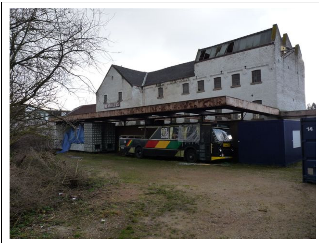
Foto 1. Noordoostzijde hoofdgebouw, voormalige sigarenfabriek te Beek.
