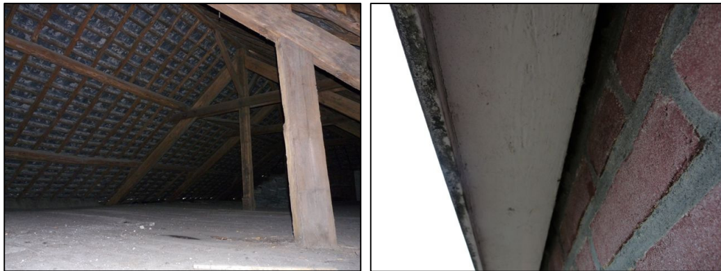
figuur 2 en 3 potentiële verblijfplaatsen voor vleermuizen op de onderzoekslocatie
