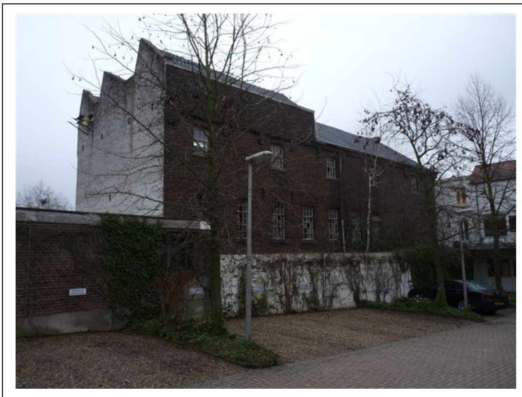
Foto 6. Zuidwest aanzicht hoofdgebouw.
