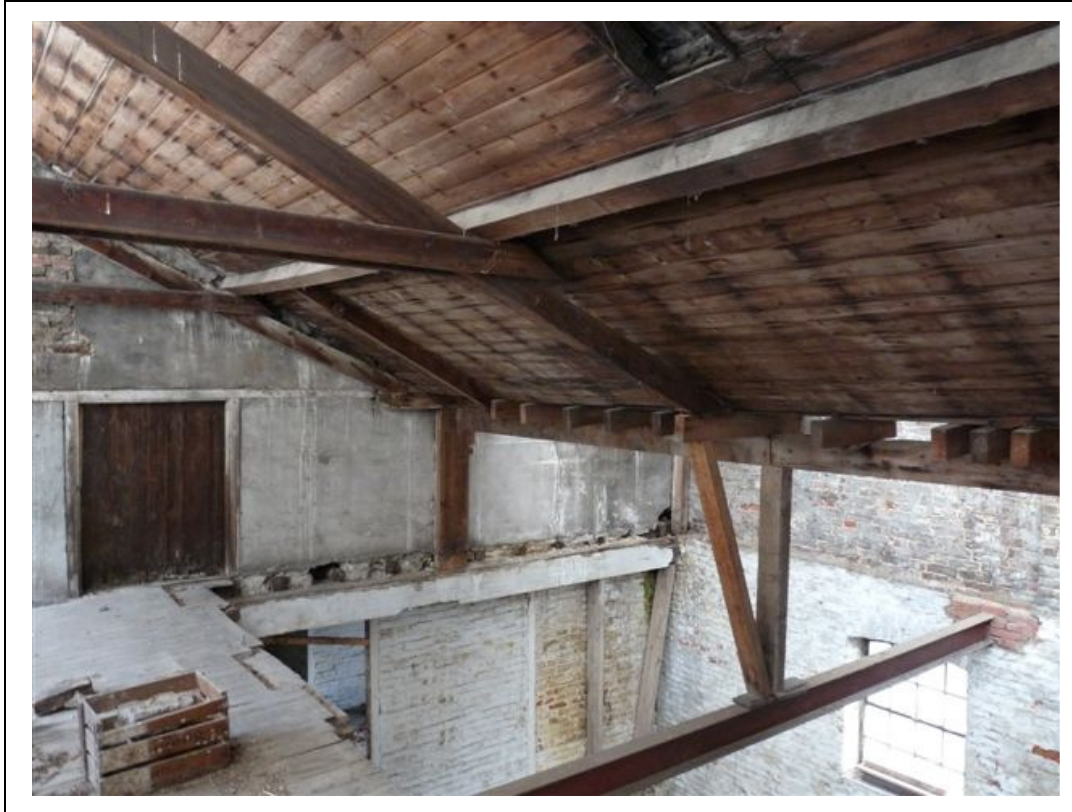
Foto 5. Binnenzijde tweede verdieping hoofdgebouw.
