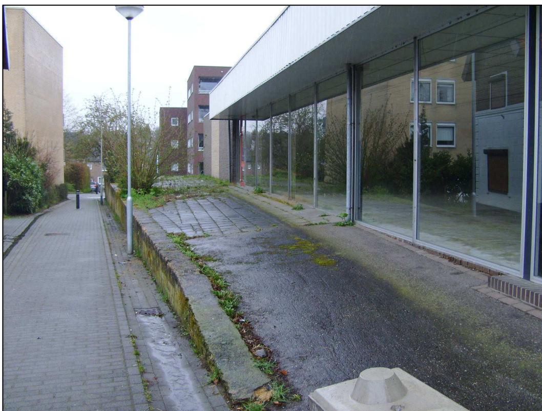
Linkergevel bestaand pand Maastrichterlaan 26 inclusief keerwand en daartussen gelegen geroerde gronden
