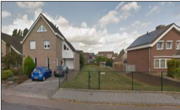
Foto's bestaande situatie
