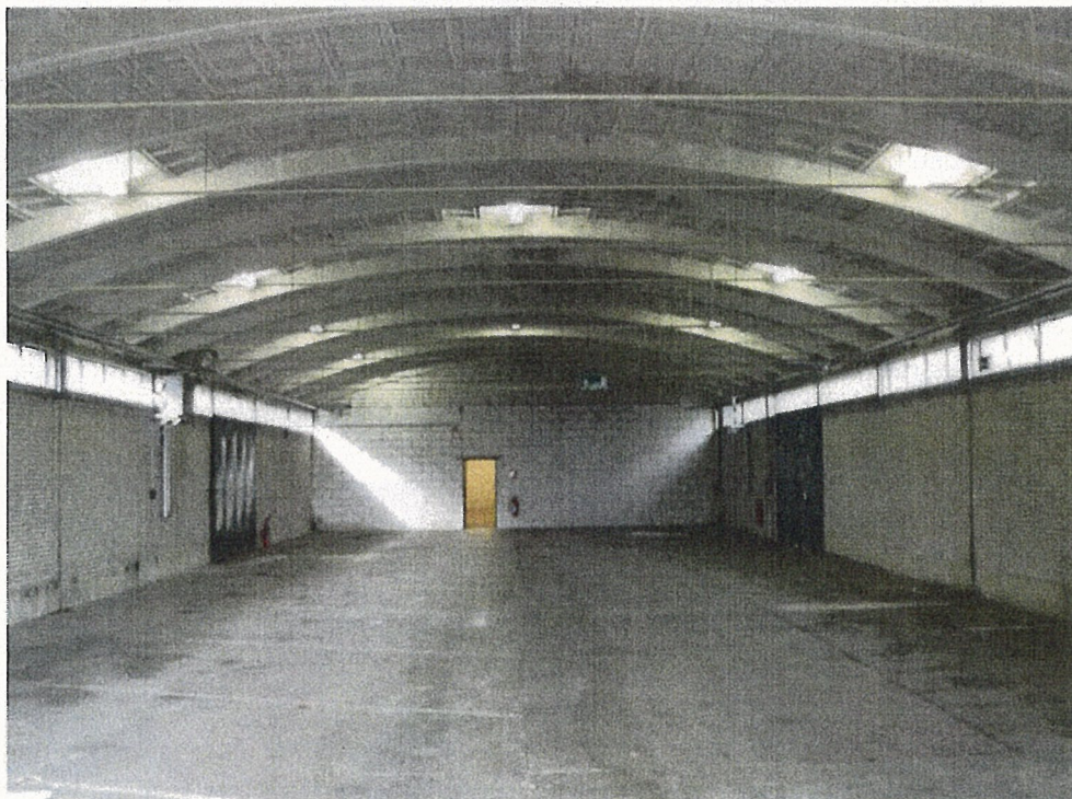
foto 3: Inwendige van loods M2 (datum: 10.10.2008)
