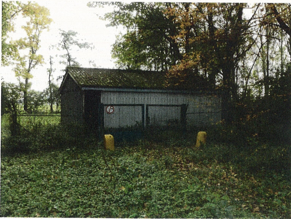
foto 9: Pomphuisje, gebouw M5 (datum: 10.10.2008)
