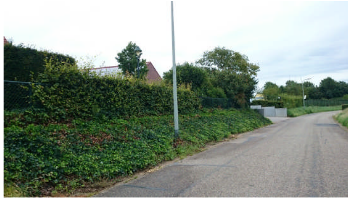
Het talud langs de Kelmonderstraat.
