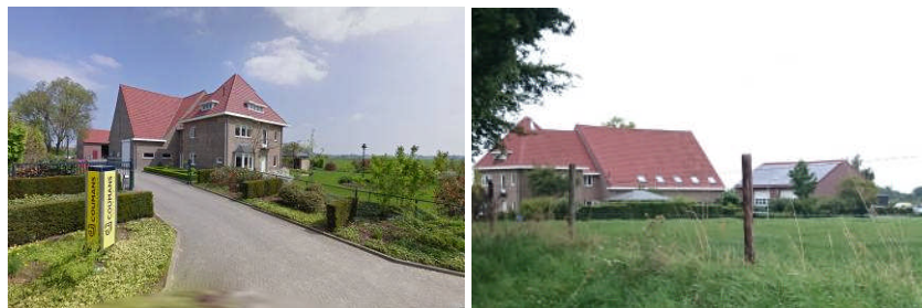
Het hoofdgebouw en de tuin aan de voorzijde (links) en de bedrijfsloods op het achterterrein. (linkerafb. Google streetview)
