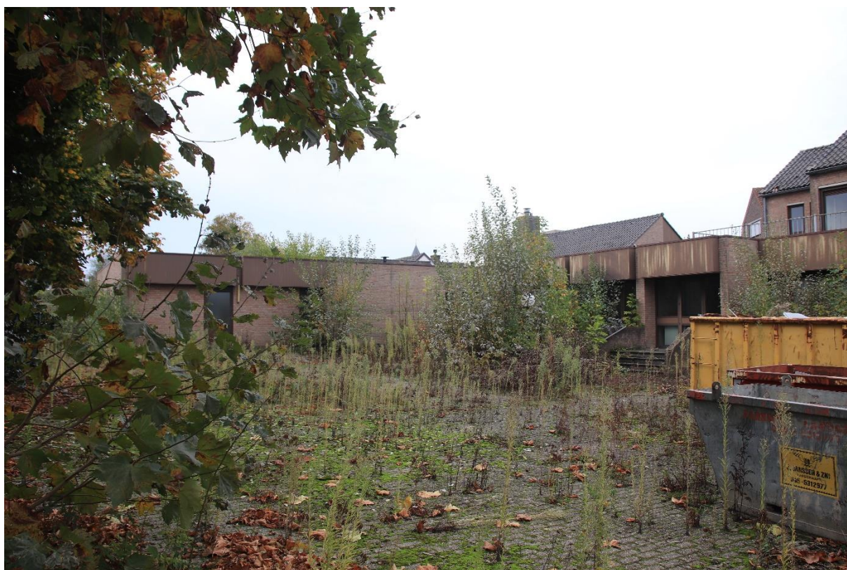
Foto 1: zicht op de achterzijde van de voormalige apotheek, gezien vanaf het binnenterrein.
