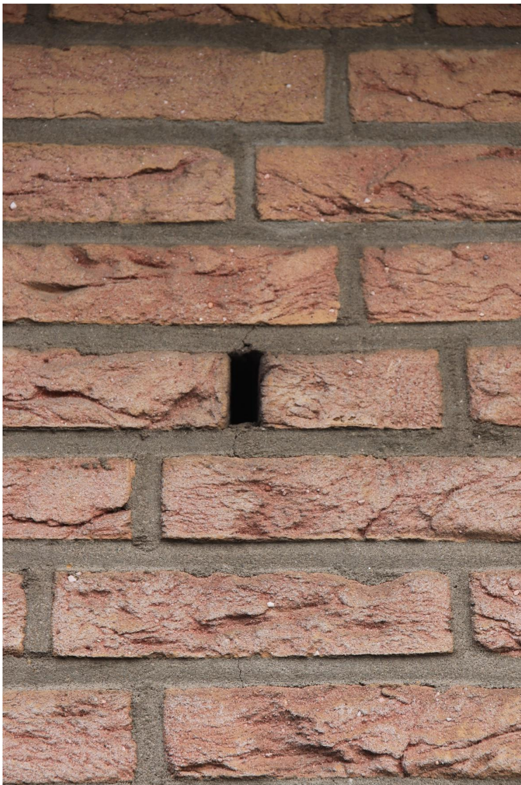
Foto 4: Open stootvoegen zijn geschikte toegangen tot verblijfplekken in de spouwmuur
