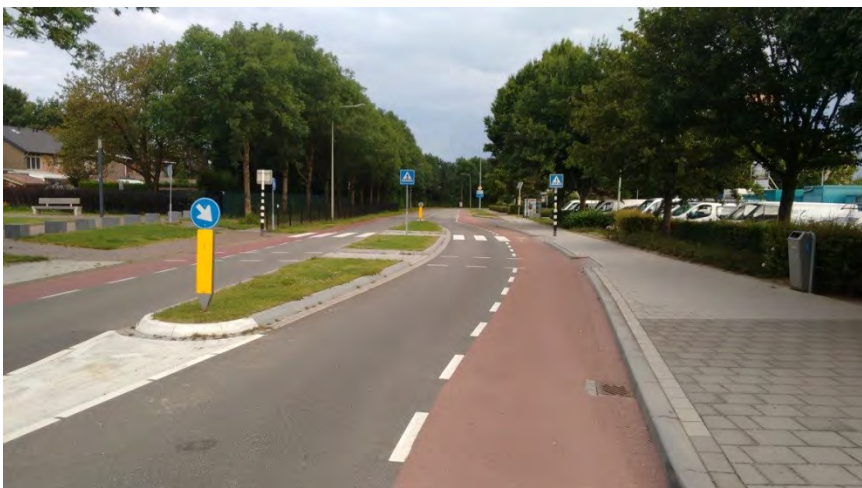
Oversteekvoorziening met brede middengeleider, VOP en LED-borden (Beethovensingel)
