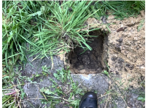
Foto 2 Asbestinspectiegat ter plaatse van boring 2
