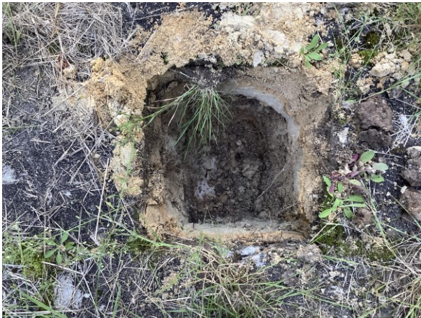
Foto 3 Asbestinspectiegat ter plaatse van boring 3
