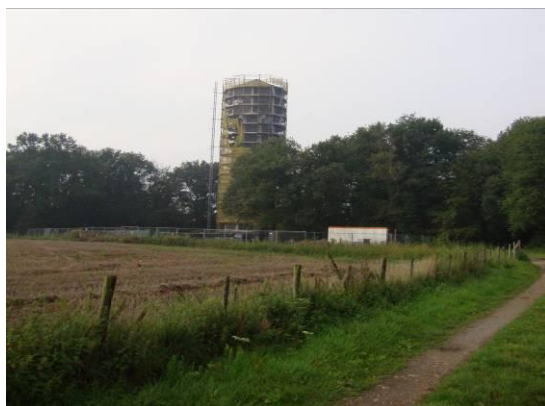
Watertoren in de steigers (huidige verbouwing)
