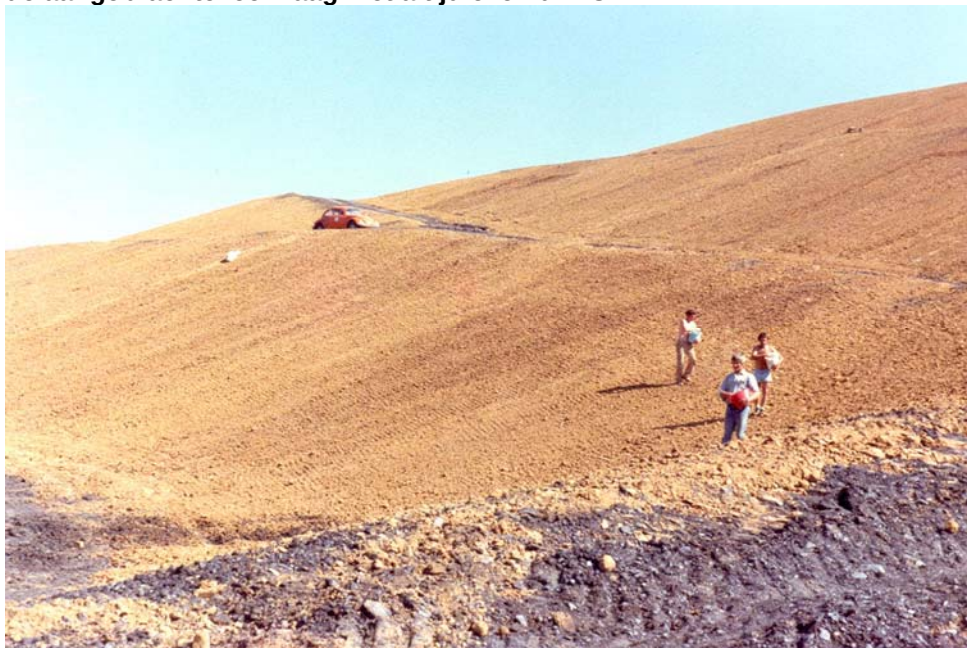
Foto 6: de mijnsteenbergr van de Wilhelmina wordt ingezaaid met gras. Duidelijk zichtbaar is dat de aangebrachte leemlaag niet altijd even dik is.
