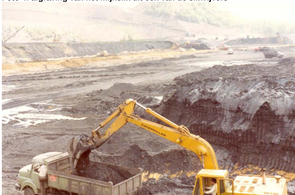
Foto 4: afgraving van het mijnslik uit één van de slikvijvers
