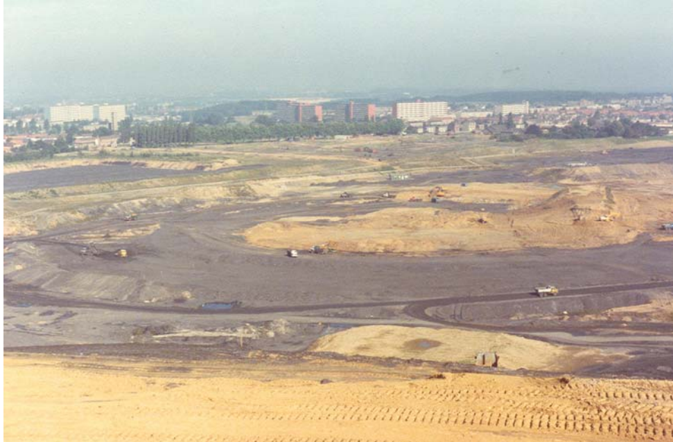
Foto 6: de mijnsteenbergr van de Wilhelmina wordt ingezaaid met gras. Duidelijk zichtbaar is dat de aangebrachte leemlaag niet altijd even dik is.
