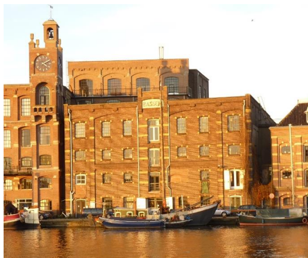
Veerdijk 41 Pakhuis Bassein
