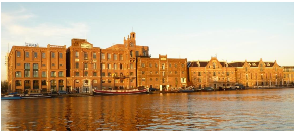
Huidige situatie Veerdijk 43 t/m 39
