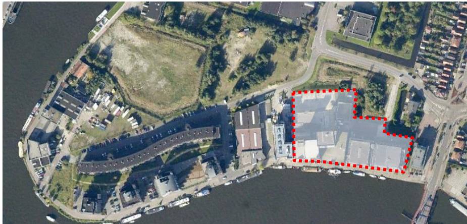
Ligging Veerdijk 39 t/m 43 (Bron: Google Earth)
