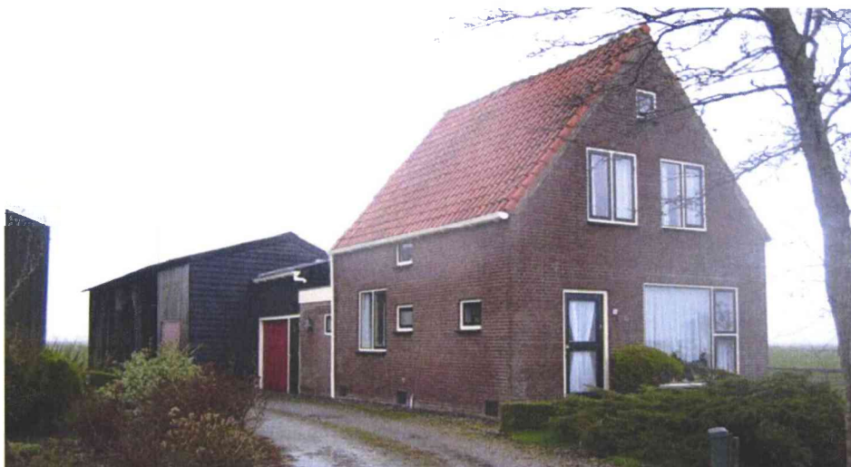
afb. 6 Huidige staat en verschijningsvorm van de bedrijfswoning c.a.
