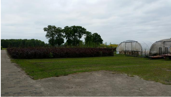
Figuur 3: Foto's bestaande situatie bedrijfsloods en tunnels
