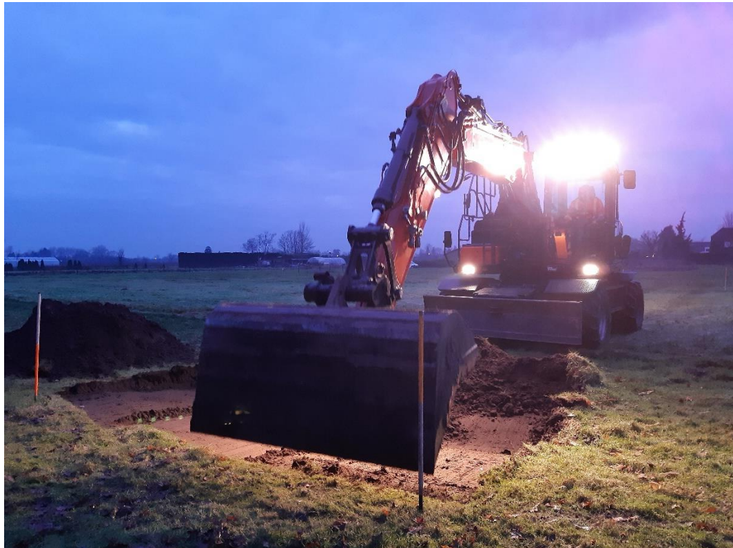
Afbeelding 3. Aanleg van één van de werkputten in de ochtend.
