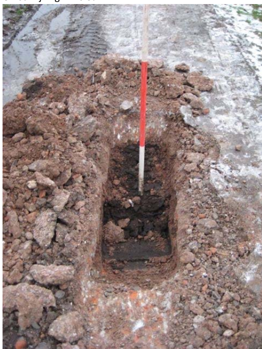
Fotonummer: 11 Omschrijving: sleuf 9
