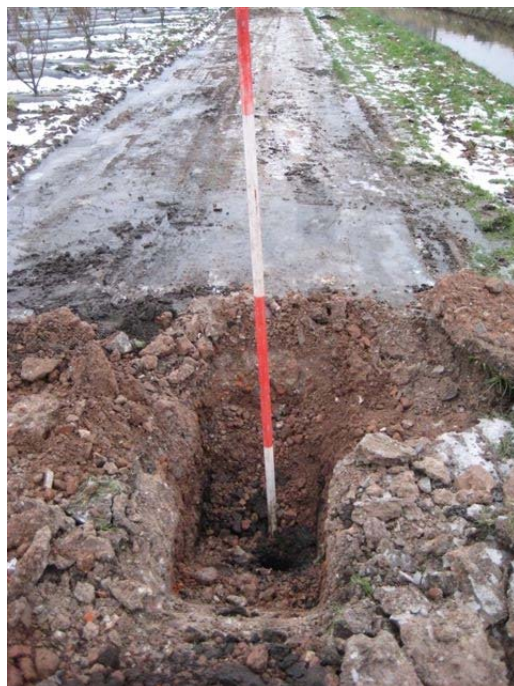
Fotonummer: 14 Omschrijving: sleuf 12
