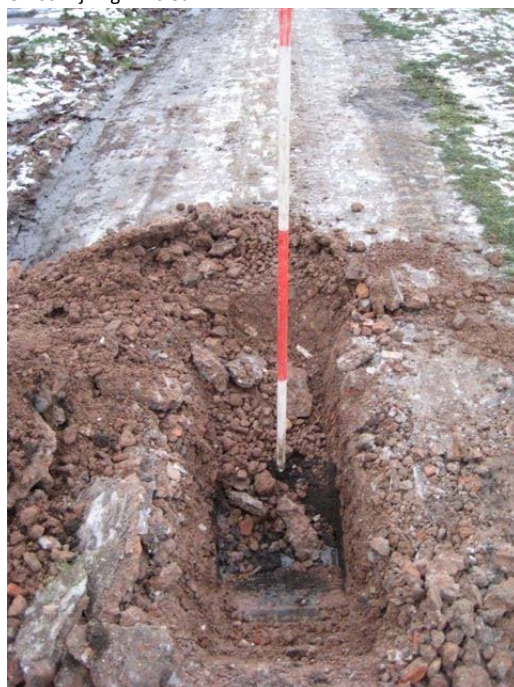
Fotonummer: 8 Omschrijving: sleuf 6
