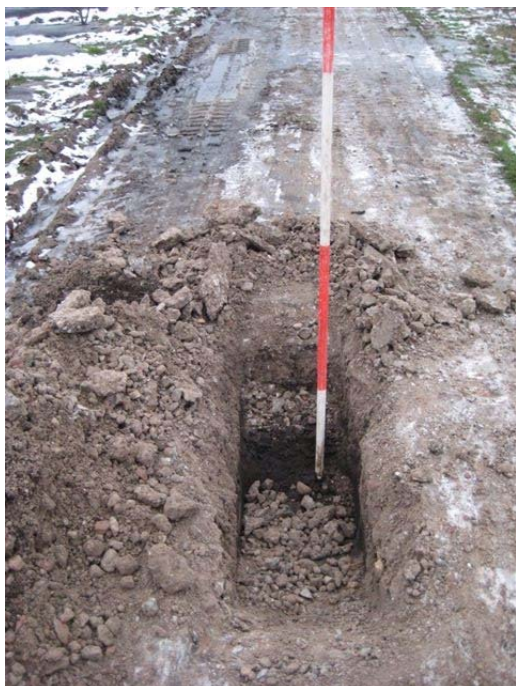
Fotonummer: 13 Omschrijving: sleuf 11
