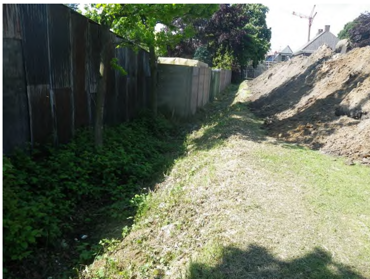
Afbeelding 3. Hoogteverschil met het naastgelegen perceel.
