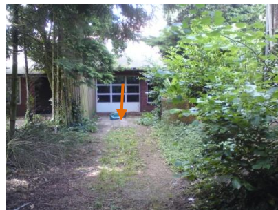
Oprit Markt 25 met aangewezen ligplaats gesaneerde HBO-tank voor de garage (→).
