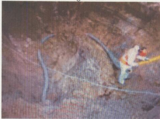
Foto 3. Overzicht aanbrengen drain
