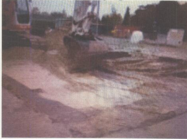
Foto 1. Overzicht ontgraven toplaag
