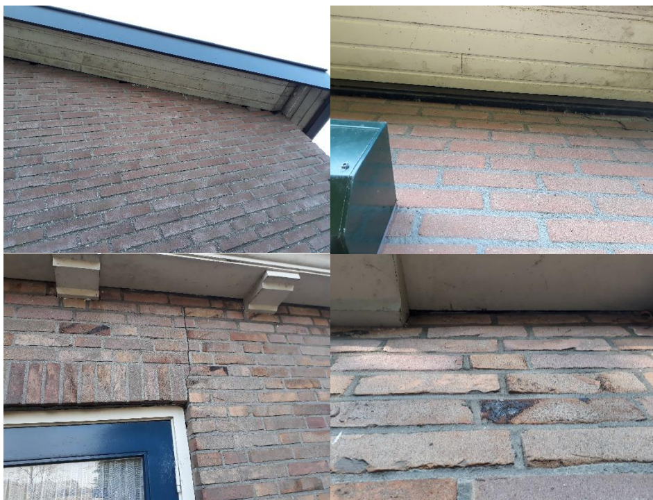
Figuur 4.4. Verschillende openingen die mogelijke geschikte verblijfplaatsen zijn. Bovenin: holtes bij de bebouwing in de Veldstraat 20. Onderin: holtes in bebouwing bij de Prinsenstraat 60.
