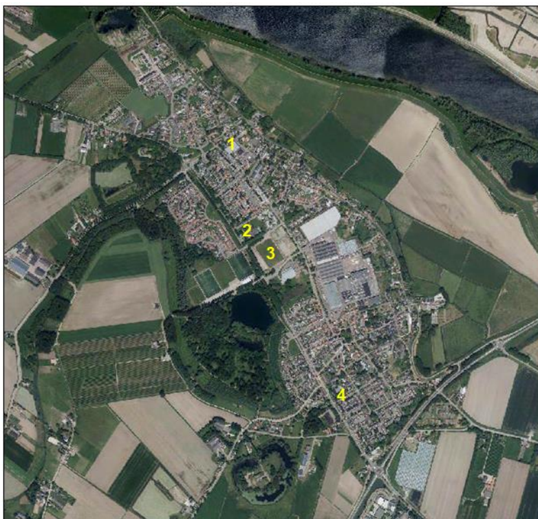
Ligging deelgebieden op een luchtfoto (Bron: Google Earth).
