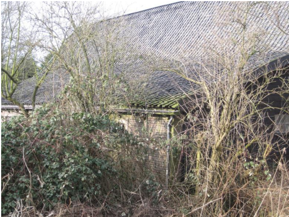
Figuur 3.5: uiterste noordoosthoek van het plangebied. Dit soort overhoeken met oude gebouwen zijn vaak belangrijk voor cultuurvolgende soorten als uilen en vleermuizen. De opstallen staan overigens net buiten het plangebied.
