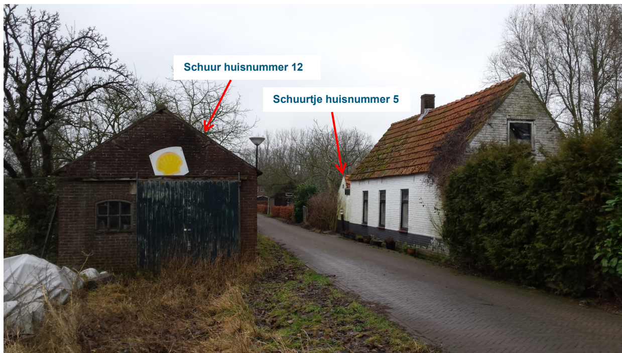
Figuur 8: Beide opstallen zijn in 2017 aangemerkt als potentieel geschikte vaste nestplaats voor huismus en gierzwaluw, maar ook als vaste paar- en verblijfplaats voor gewone grootvleermuis en gewone dwergvleermuis. De schuur van huisnummer 12 is inmiddels gesloopt, nadat in 2018 is gebleken dat de opstallen geen essentiële verblijfsfunctie hebben voor vleermuizen en vogels met een jaarrond beschermd nest
