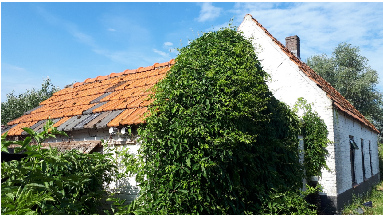
Figuur 3: Het te slopen woonhuis aan Bronkhorst nummer 5. Opnamedatum: 28 juni 2021.
