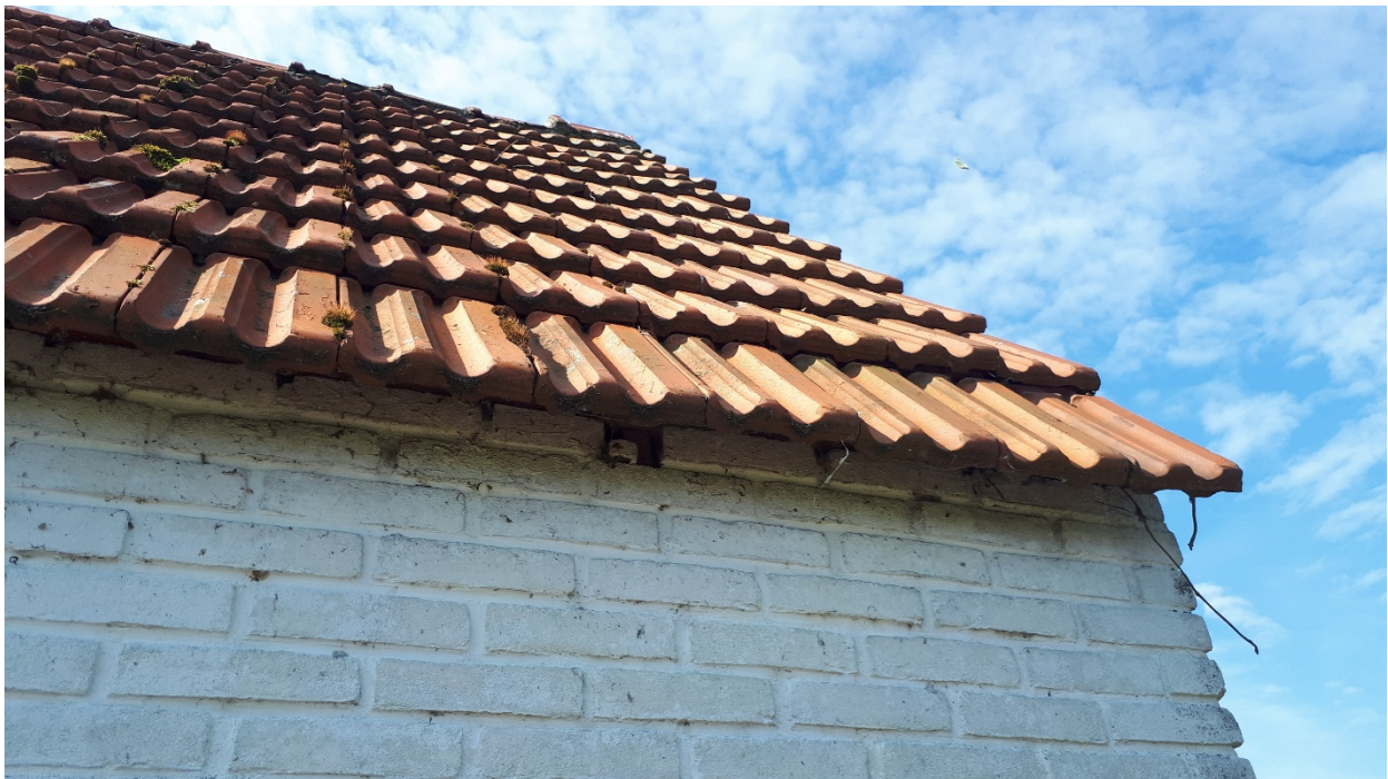
Figuur 7: Het pannendak van huisnummer 5 biedt toegang tot potentiële verblijfplaatsen voor vleermuizen, maar ook potentiële nestplaatsen voor bijvoorbeeld huismus. Uit nader onderzoek (Econsultancy, 2018) is echter gebleken dat er geen vaste rust- en verblijfplaatsen van deze soorten zijn aangetroffen, ondanks potentiële geschiktheid.
