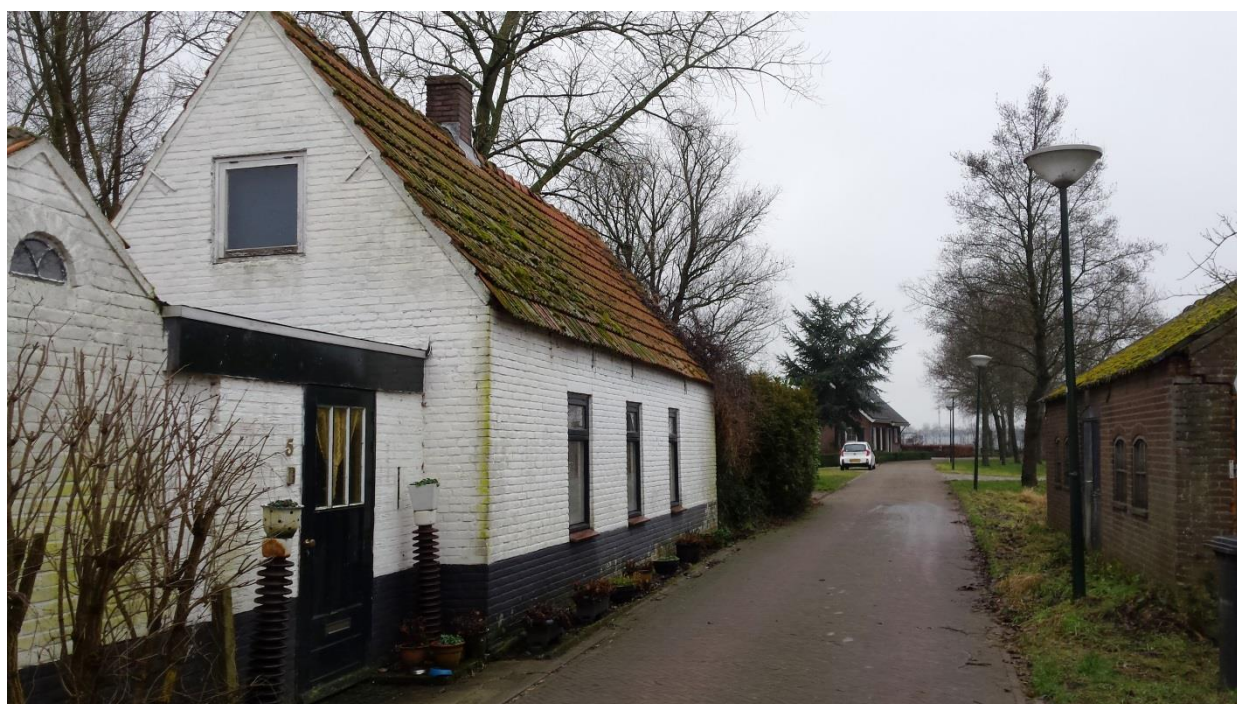
Figuur 3: Het te slopen woonhuis aan Bronkhorst nummer 5.
