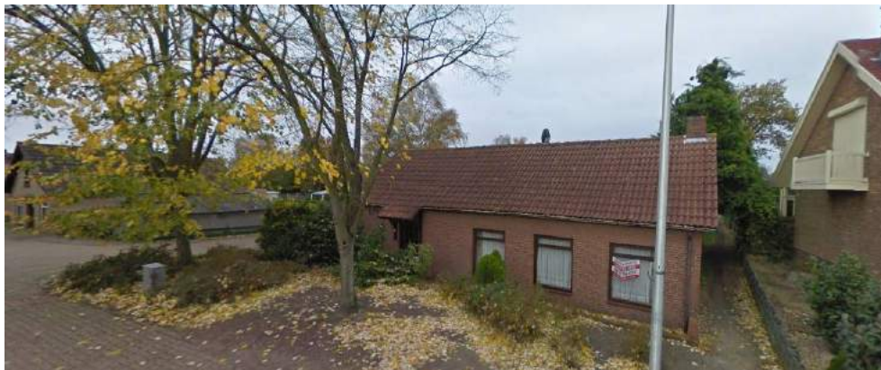
Afbeelding 5 - Bestaande woning De Kuil 9 (bron: Streetview, geraadpleegd juni 2015);
