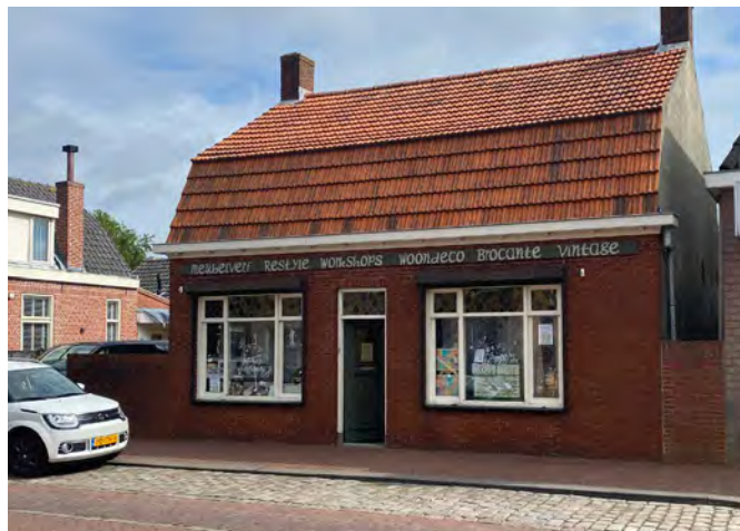
Figuur 3.6: Huidige bebouwing plangebied
