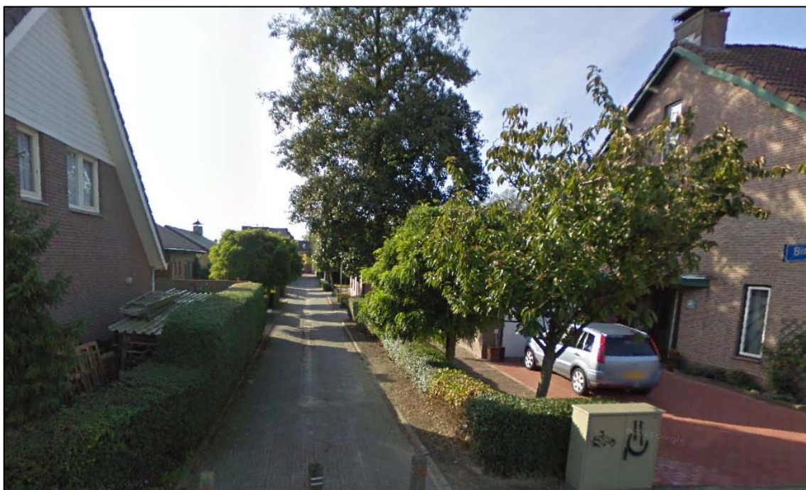
Aanzicht van de Prins Bernhardstraat ter hoogte van de Binnenweg. De Prins Bernhardstraat loopt van de Raadhuisstraat naar de Wouwbaan, maar is tussen de Raadhuisstraat en de Binnenweg onderbroken. Vanuit het oosten is dit deel van de straat niet bereikbaar voor bestuurders van motorvoertuigen.
