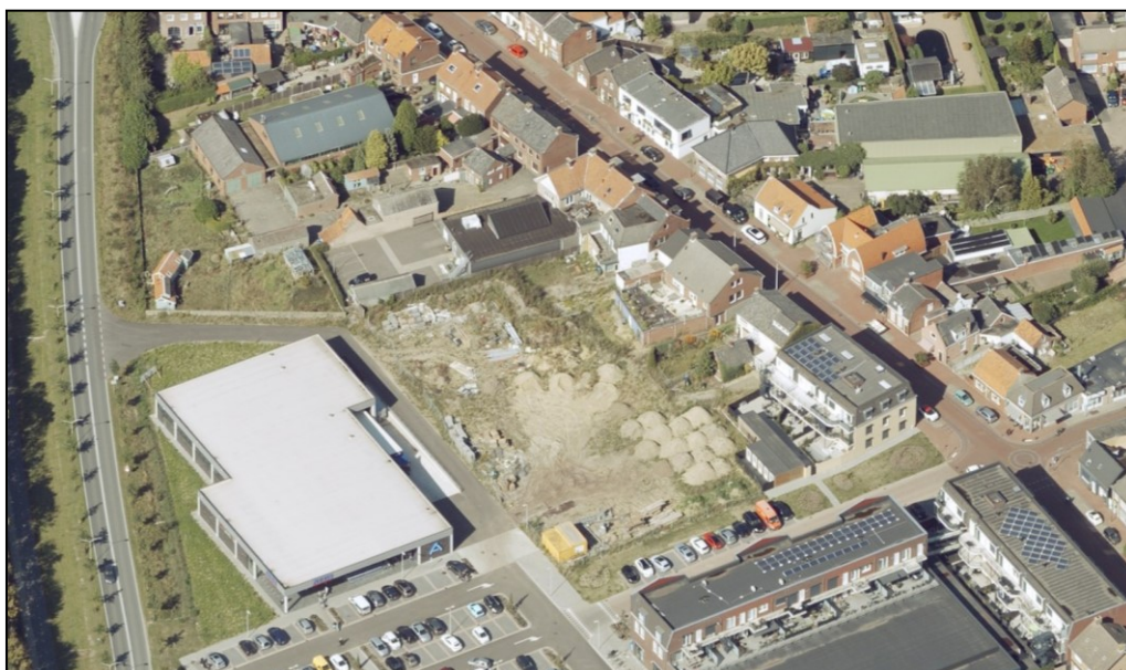
Het plangebied in vogelvlucht gezien. Bron: StreetSmart, 2020
