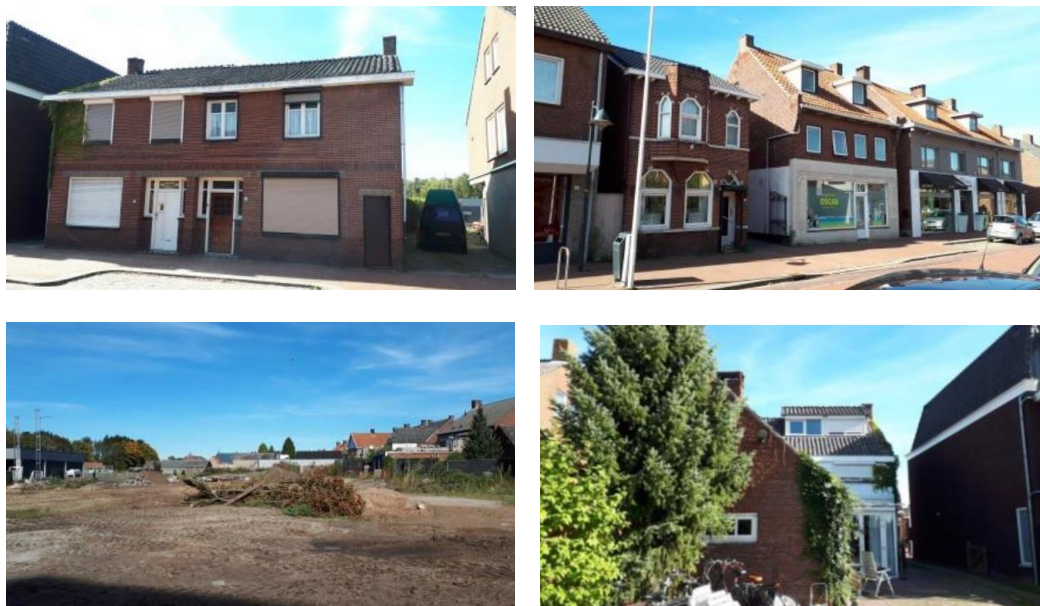
Figuur 1.2 De planlocatie bestaat uit woningen en winkelpanden aan de Raadhuisstraat 20-32 te Hoogerheide. Aan de achterzijde van de panden is sprake van een braakliggend terrein (bron foto's: Sanders, 2019).
