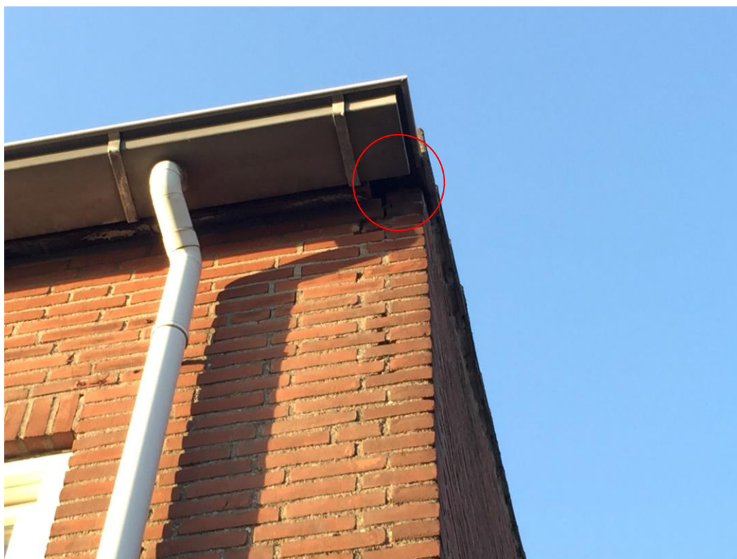
Figuur 3.4 De nestlocatie van gierzwaluw aan de achterzijde van het pand aan de Raadhuisstraat 28 te Hoogerheide.
