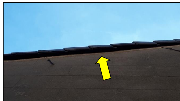
Figuur 13. Geschikte ruimte voor gierzwaluwen en vleermuizen onder de dakpannen.
