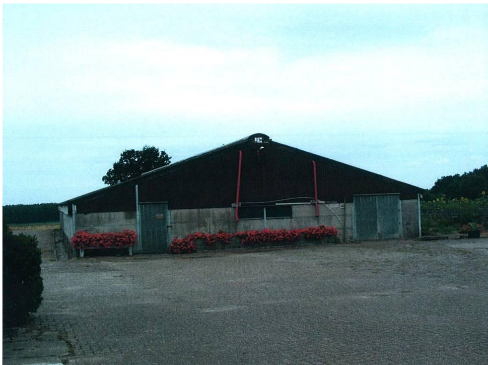
Afbeelding 6 - Voormalige ligboxenstal - deze zal worden geamoveerd
