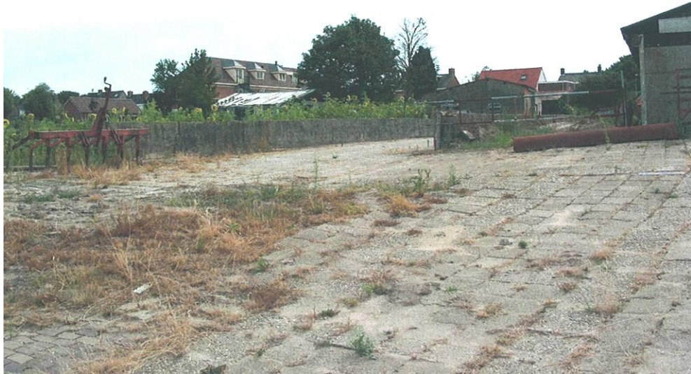
Afbeelding 7 - Sleufsilos en achterterrein
