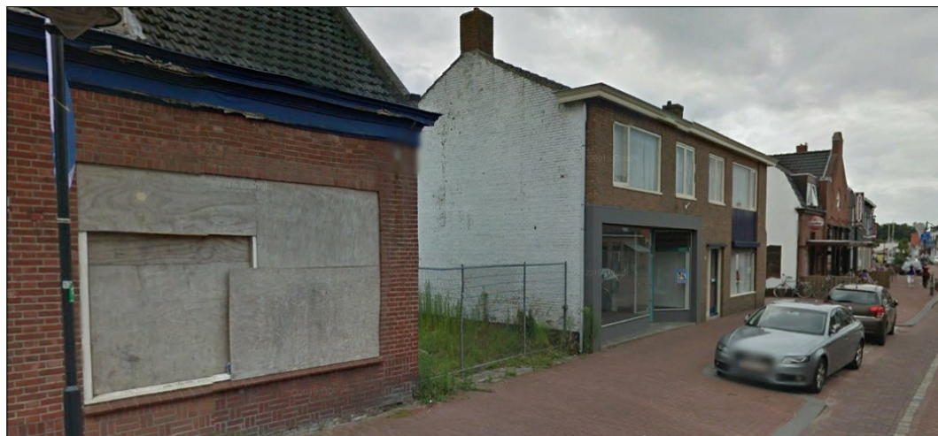
Impressie van de bestaande bebouwing aan de Raadhuisstraat. Bron: Google streetview 2016
