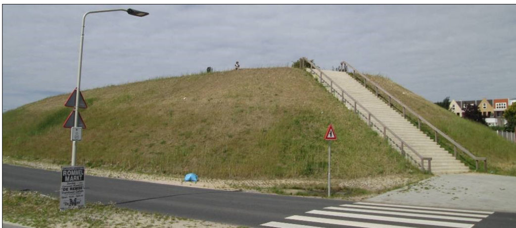
Het van beplanting ontdane talud
