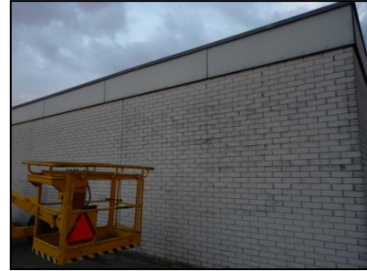
Figuur 15. Open stootvoegen.
