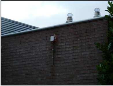
Figuur 13. Open stootvoegen.
