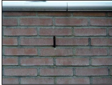
Figuur 14. Open stootvoegen.
