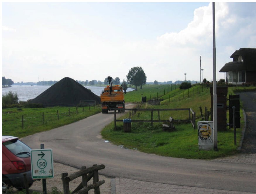
Foto 1 - westelijk terreindeel (insteekhaven)
