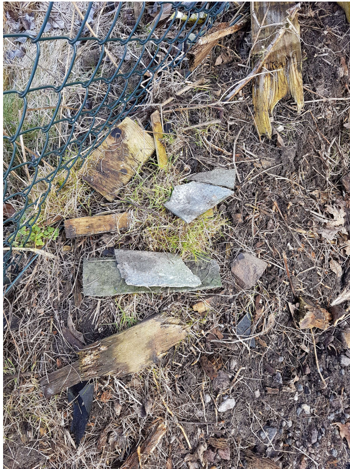
Foto 3: Asbestverdacht plaatmateriaal op maaiveld.
