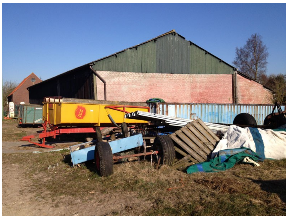
Figuur 3. Oostgevel van de af te breken grote schuur.
