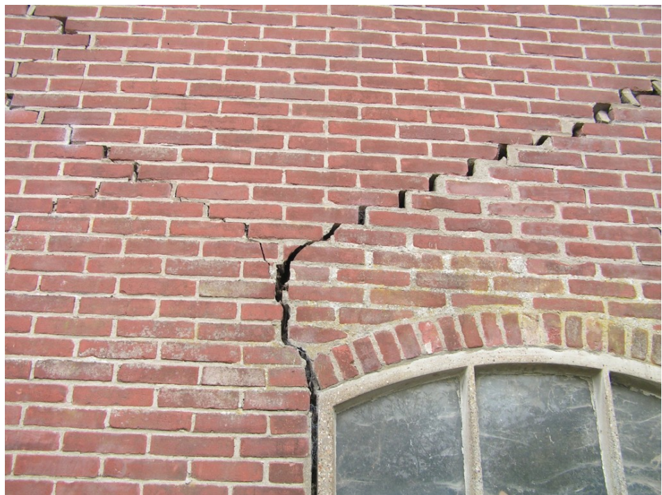
Figuur 3. Scheur in de muur die de tussenruimte toegankelijk maakt voor vleermuizen.
